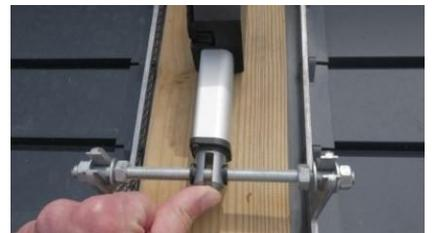
4. Drücken Sie leicht auf den Rotor oder die Gabel, die vor der Befestigung des Halters vollständig geschlossen sein sollte.
