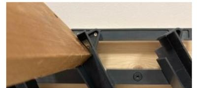
6. Heben Sie die Klinken des Platteneinbauwinkels an, so dass er sitzt.
