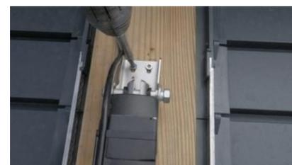
4. (Bis) Befestigen Sie die Stütze und achten Sie darauf, dass die Latten der Pergola immer geschlossen sind.
