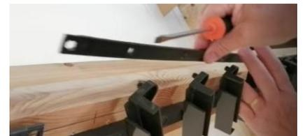
2. Schrauben Sie den PVC-Verbindungsstreifen mit einem Schraubendreher von den Halterungen ab. Verwenden Sie eine Zange, um die Halteklammern zu entfernen.
