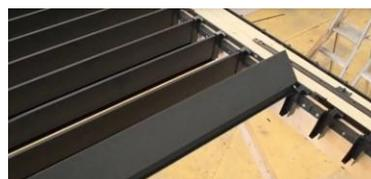
7. Legen Sie die Lamellen in den Halter ein, indem Sie abwechselnd die linke und die rechte Seite einrasten lassen.
