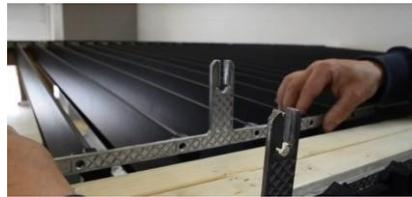
1. Setzen Sie die Gabel mit den Stäben wieder ein, indem Sie sie in den Lamellenhalter einrasten lassen. Sichern Sie die Einheit mit den Riegeln.
