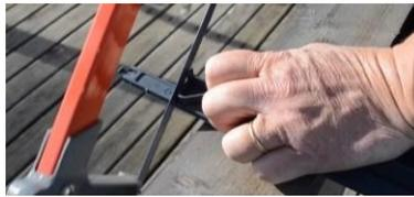
1. Schneiden Sie den Starterclip mit einer Säge ab. 2. Platzieren Sie das SAM KIT mit 7 mm Abstand, Verbindungsschienen innen.
