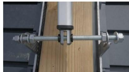
3. Schließen Sie die Pergolalatten mit der Hand und stecken Sie den Gabelbolzen in beide Stäbe.
